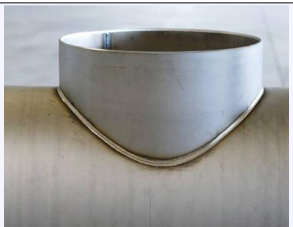
Slika 05.03 Zavarivani spoj cjevovoda
